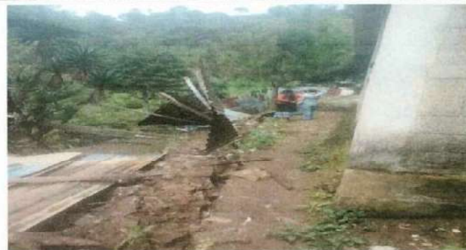
Foto 4: reparación de tosta y de muro exterior
