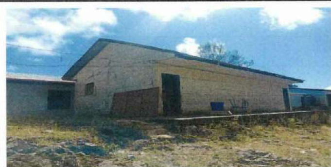
Foto 5: pintura de interior y exterior y repello
